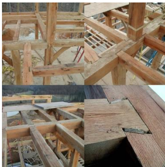
Рис. 1. Стійки круглого і квадратного перерізу
